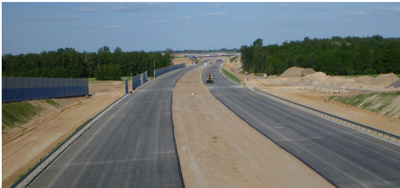
Budowa Autostrady A2, fot. Michał Siejda
