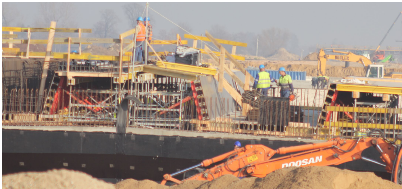
Budowa Autostrady A2, fot. Michał Siejda
