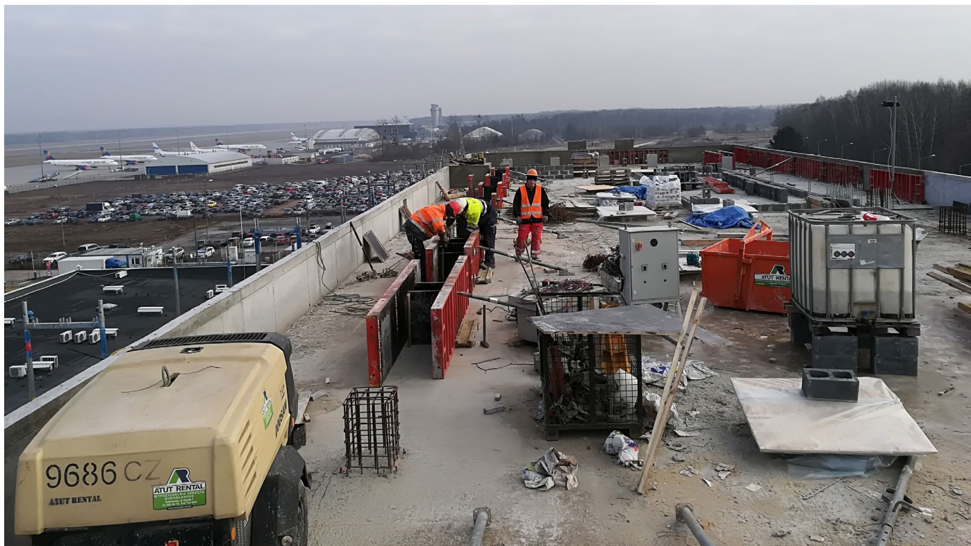
Budowa hotelu MOXY w Pyrzowicach, fot. Grzegorz Duakata
