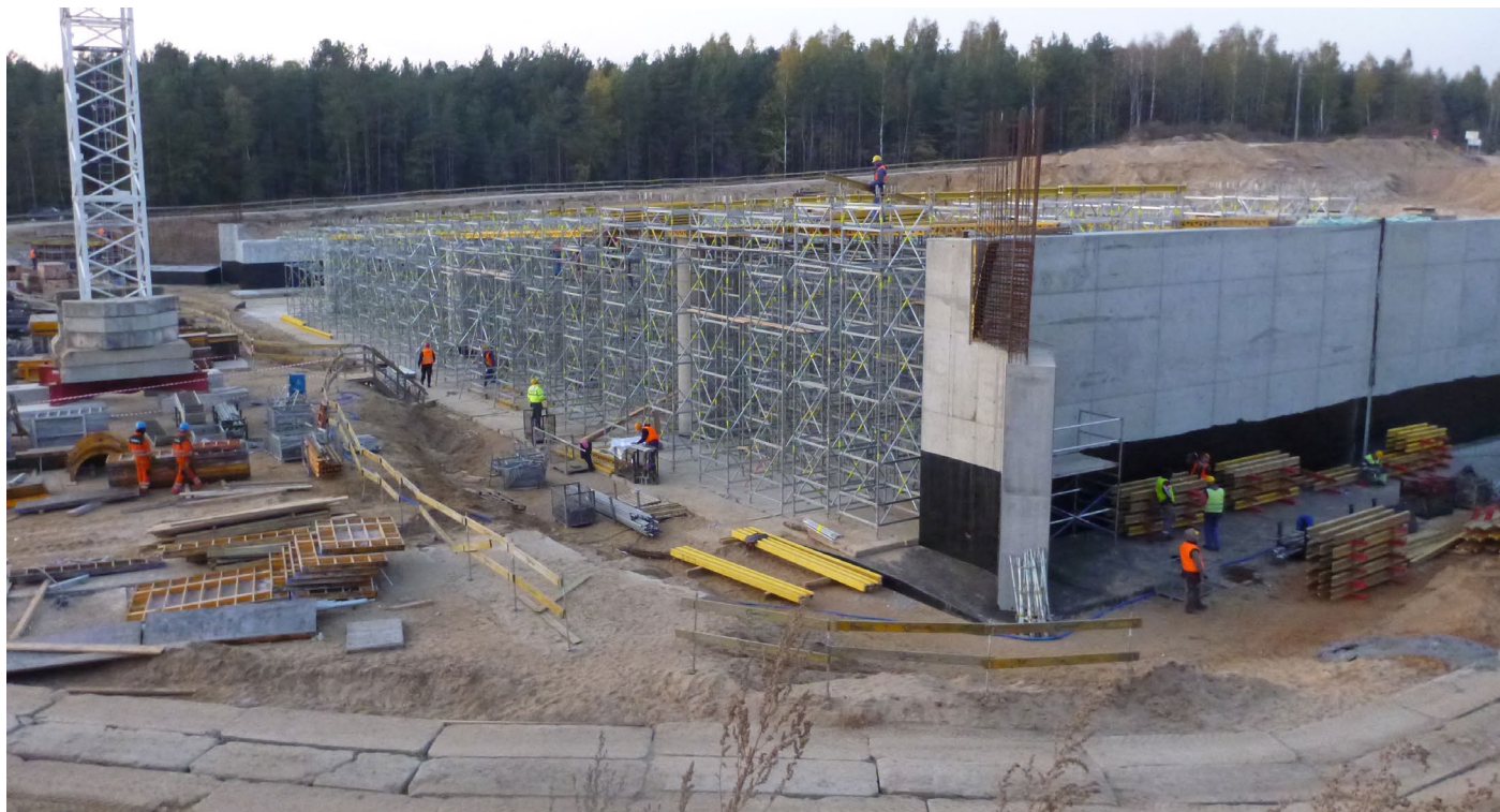
Budowa autostrady A2, fot. Michał Siejda
