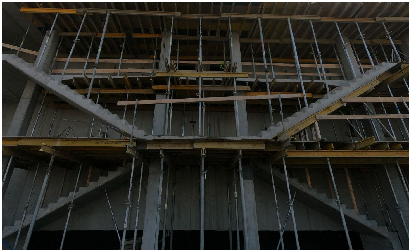
Budowa biurowca Silesia 4 Business w Katowicach, fot. Grzegorz Dukata
