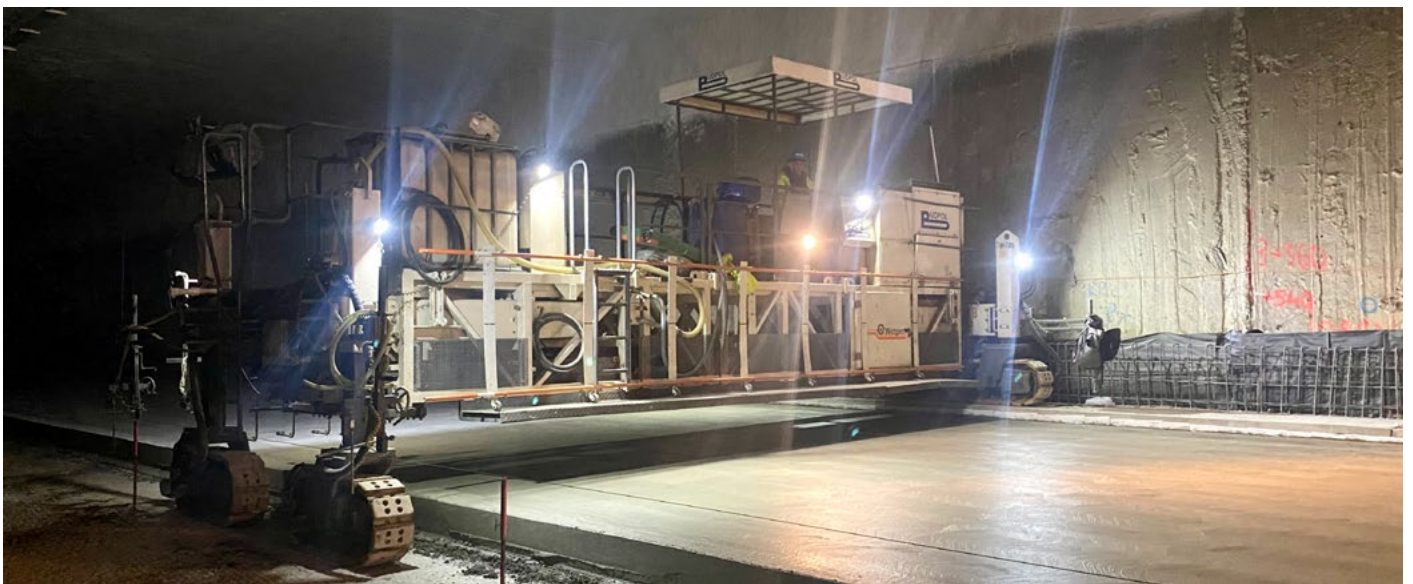
Południowa Obwodnica Warszawy, Zadanie A, fot. Katarzyna Adaszyńska, wykonawca: Astaldi
