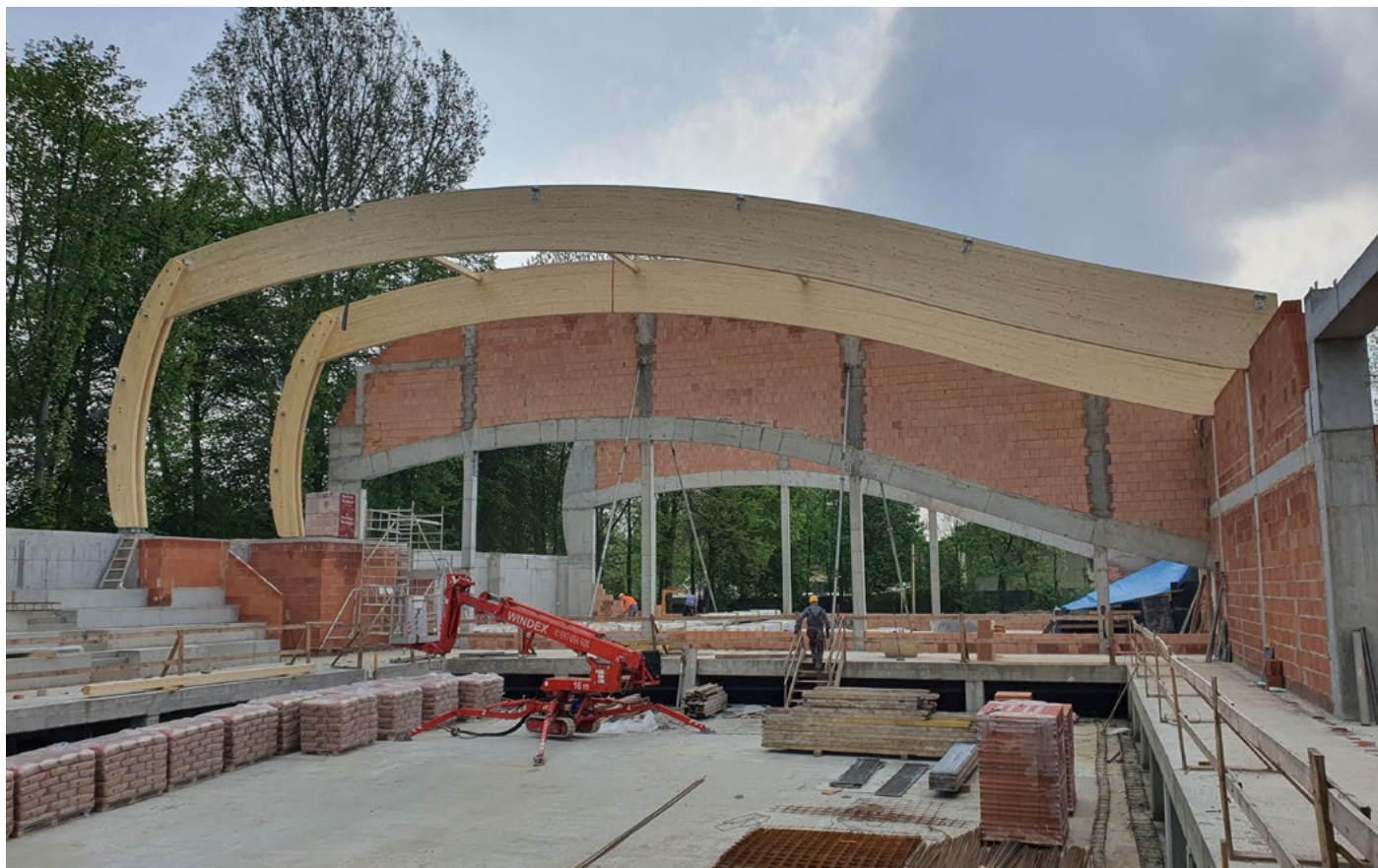
Budowa basenu Katowice ul. Wczasowa, fot. Grzegorz Dukata, wykonawca: ERBUD
