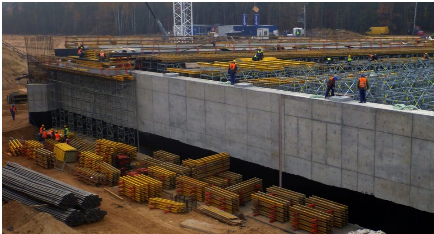
Budowa przejścia dla zwierząt. Autostrada A2. 2011 r., fot. Michał Siejda, wykonawca: EUROVIA
