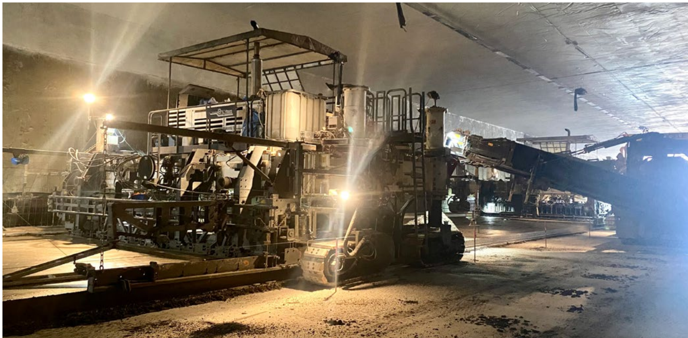
Południowa Obwodnica Warszawy, Zadanie A, fot. Katarzyna Adaszyńska, wykonawca: Astaldi
